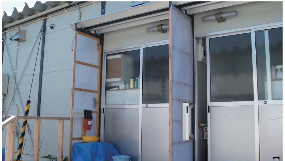
図4 仮設住宅（北側，玄関付近）
