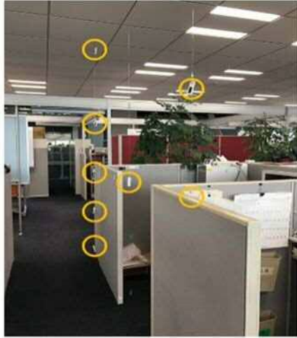
図 4.3 センサの設置状況
