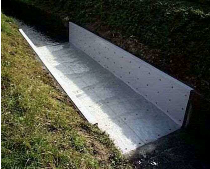
Fig. 3-15 補修後の水路の状況
