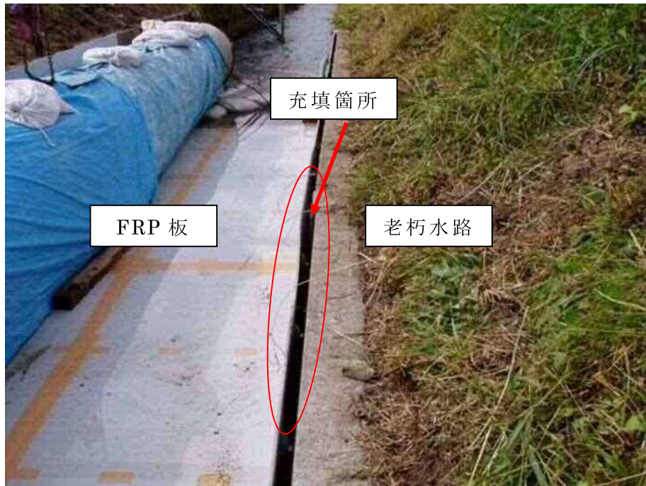
Fig. 3-10 充填箇所
