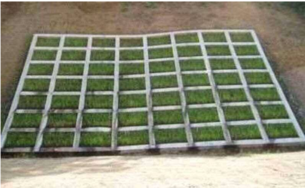
Fig. 5-12 2ヶ月後の法面の状況
