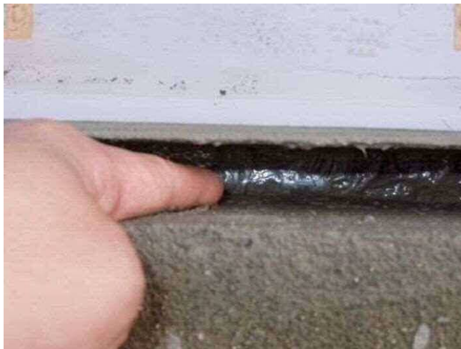
Fig. 3-11 充填箇所 (拡大)
