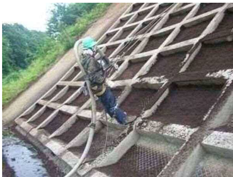
Fig. 5-10 緑化基盤材の吹付け状況
