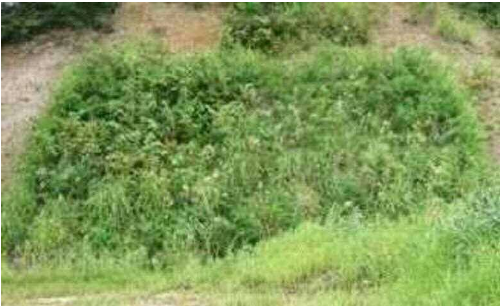
Fig. 5-14 6年後の法面の状況
