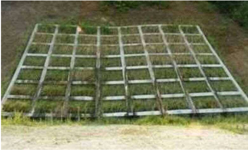
Fig. 5-13 14ヶ月後の法面の状況
