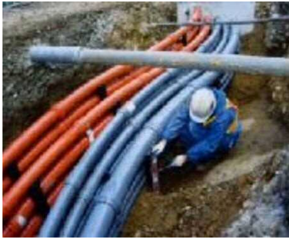
写真(3) - 32 電線類の地中化工事
