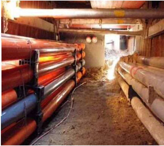
写真(2) - 8 電線類の共同埋設施設 5)
