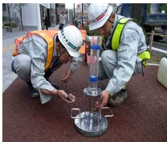
写真 (3) -24 アスファルト舗装の透水量試験
