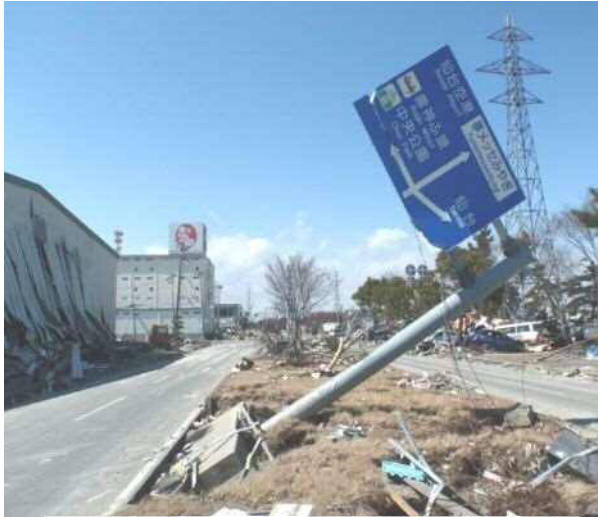
写真Ⅳ－３ 港背後地内の津波被害
