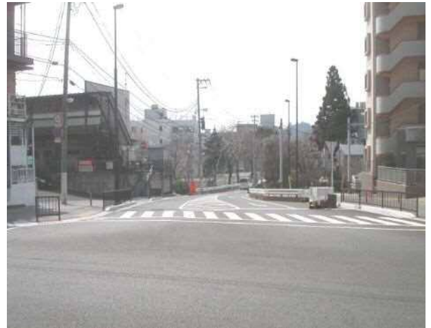
写真Ⅳ－10 拡幅された交差点
