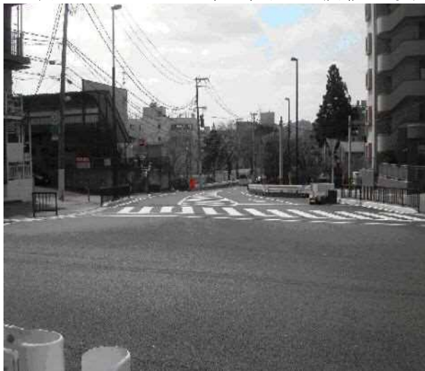
写真(4)-11 完成した交差点改良工事
