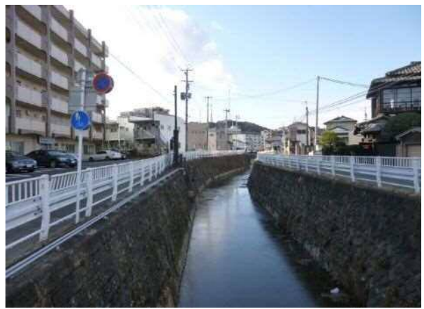
写真Ⅱ－16 広瀬川を利用した環境用水
