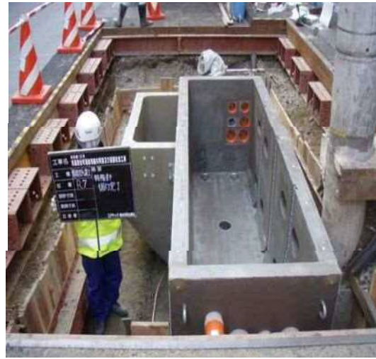
写真(2) - 9 電線ボックスの設置
