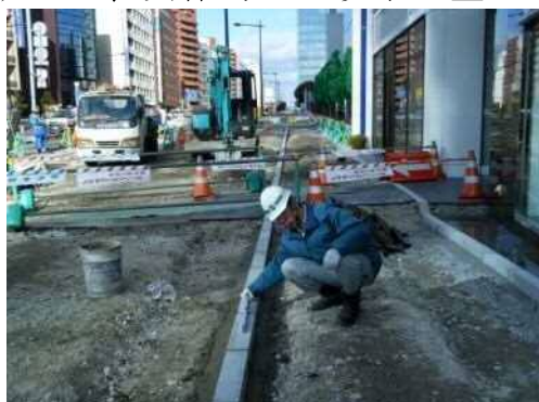
写真(3) - 3 歩道の勾配管理
