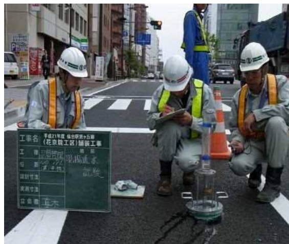
写真 (3) -22 車道の現場透水量試験
