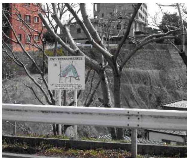
写真(4)-3 急傾斜地指定されている谷地地形
