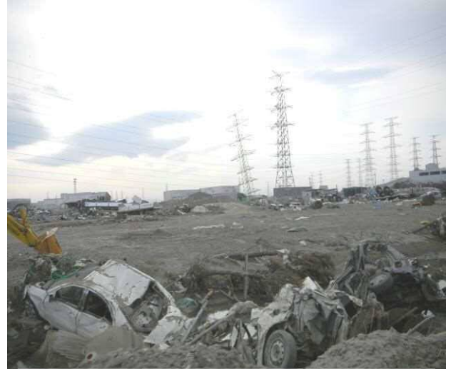
写真Ⅳ－４ 震災直後の仙台港背後地
