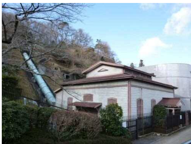
写真Ⅱ-17 現在も稼働している水力発電所
