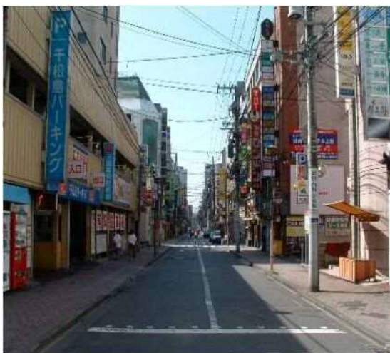
写真(2) - 1 再整備前
