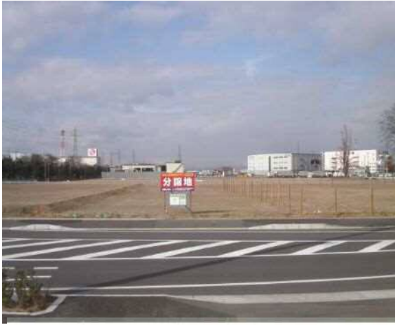
写真Ⅳ－１ 基盤整備が完了した工業地区
