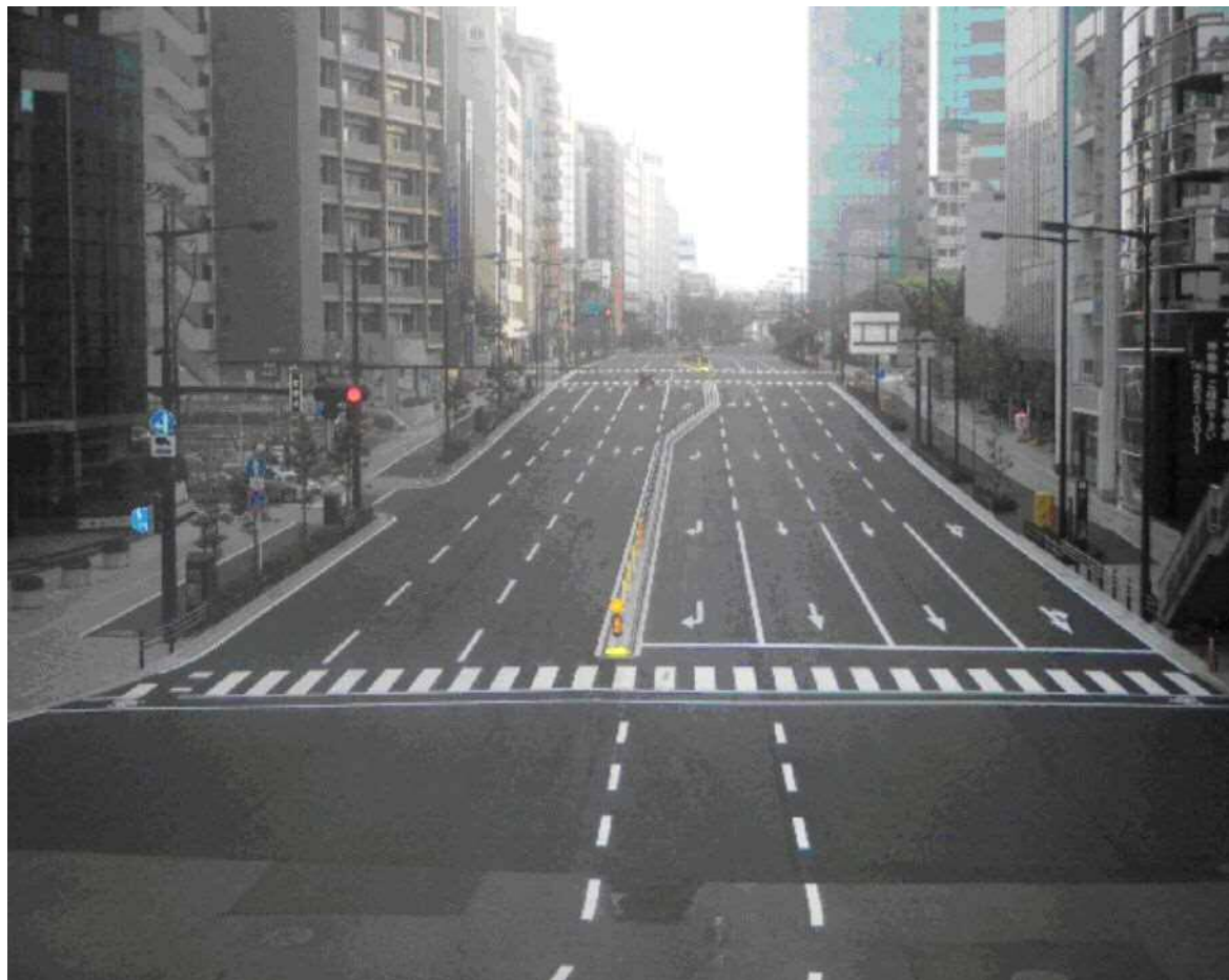
写真（3）-6 仙台駅旭ヶ丘線（花京院工区）の完成
