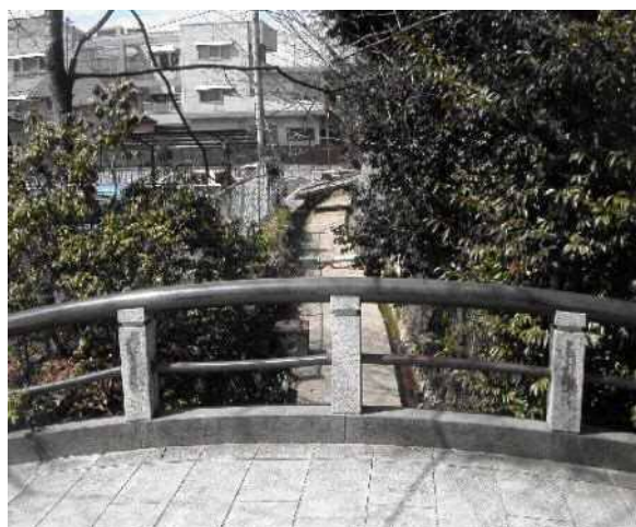
写真(4) -6 大崎八幡宮境内の四ツ谷用水遺構
