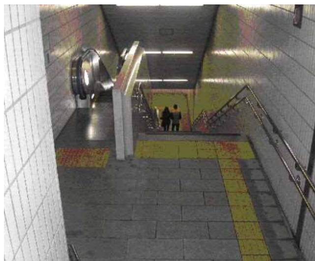
写真(4) -21 途中で途切れるエスカレーター
