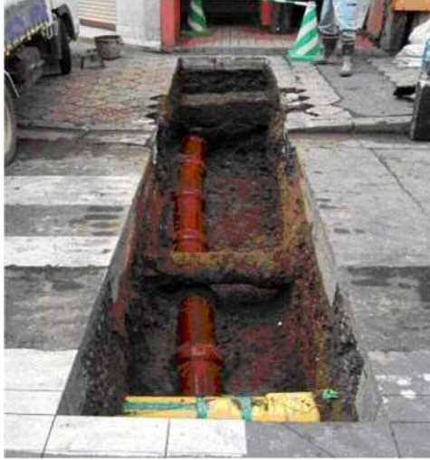
写真(2)－6 老朽化した陶管φ150mm 写真(2)－7 対荷力のある塩ビ管に交換
