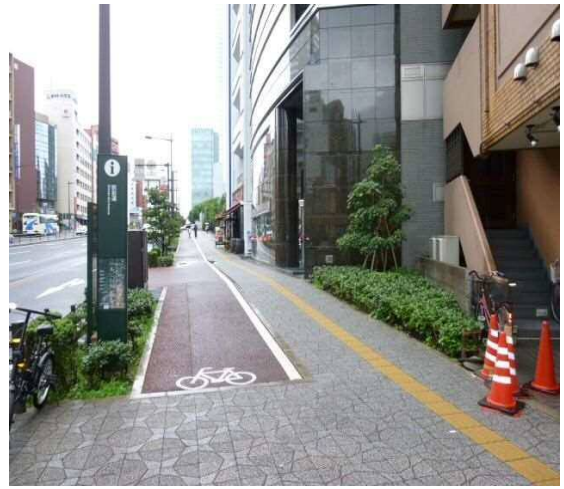
写真(3) - 18 拡幅整備した歩道
