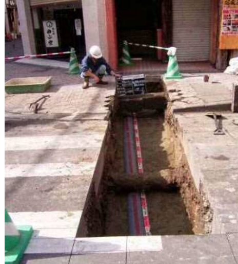
写真(2)－6 老朽化した陶管φ150mm 写真(2)－7 対荷力のある塩ビ管に交換
