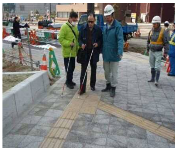
写真 (3) -12 誘導ブロックの検証
