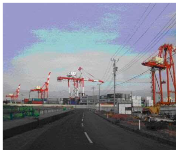
写真(1) -4 コンテナ貨物と4基のガントリークレーン
